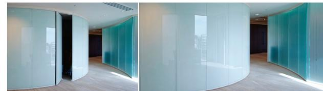
*Eine „Tapetentür“ ermöglichte den Designern, eine unterbrechungsfreie, gebogene Glasfläche zu realisieren*
